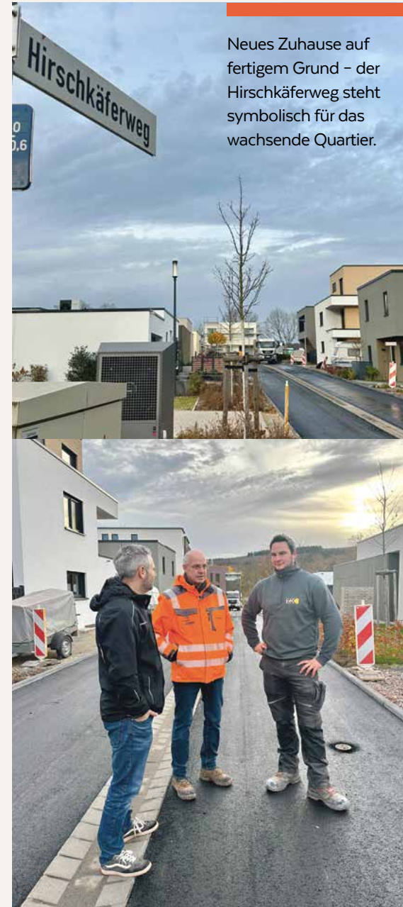
Abschließende Runde im Team – der Endausbau nimmt sichtbare Formen an.
